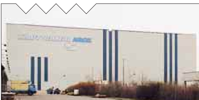
Der Erweiterungsbau des neuen Hochregallagers
