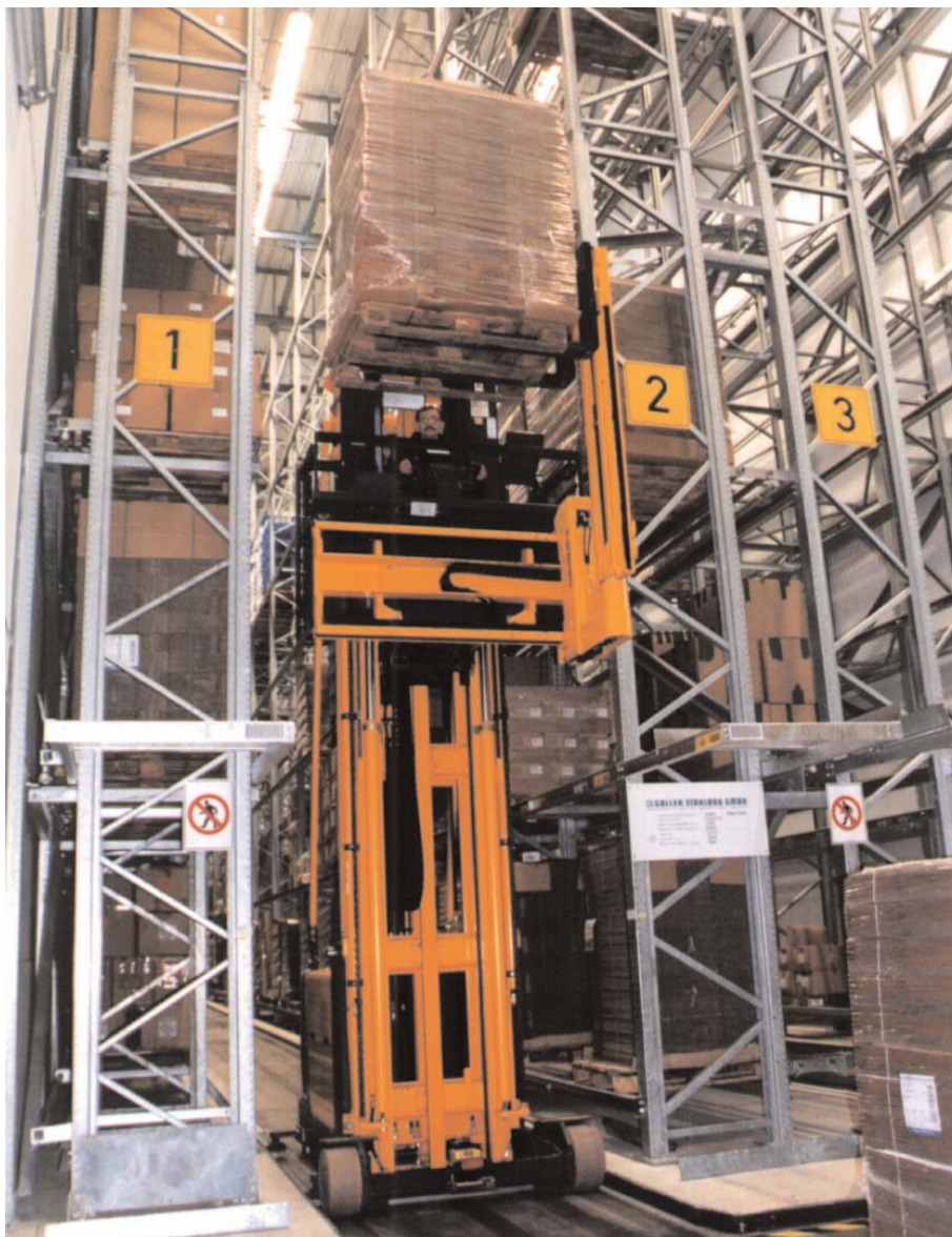
Hochregalbereich im Regalbediengerät (Regalkopf)
