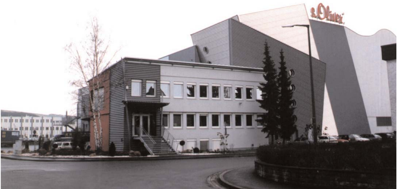
Logistikzentrum in Rottendorf bei Würzburg
