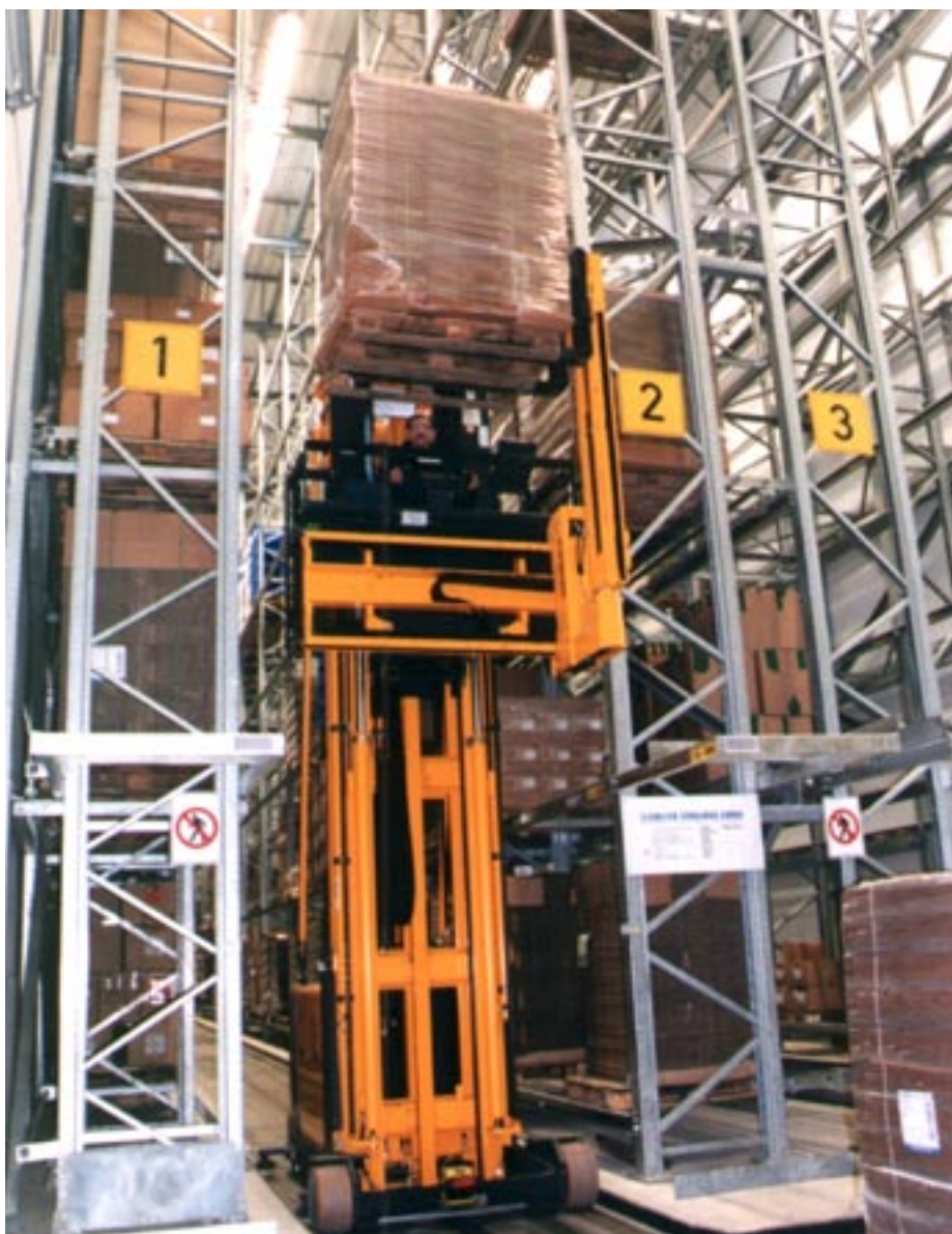
Zone au magasin à grande hauteur dans la grue (tête de rack)
