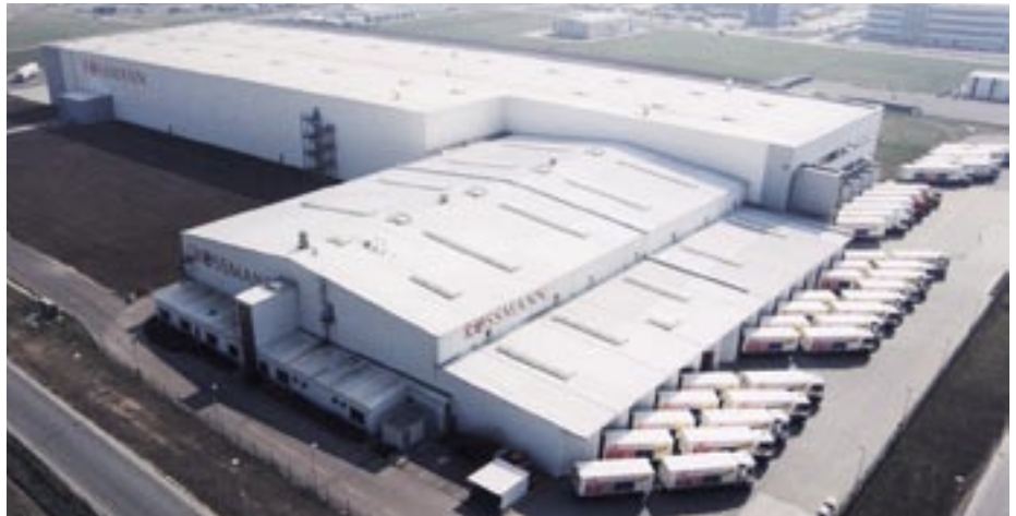
Centrale de l'entreprise Rossmann
