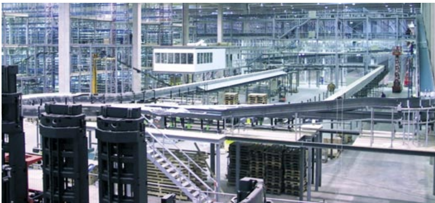
Vue de l'intérieur de l'entrepôt
